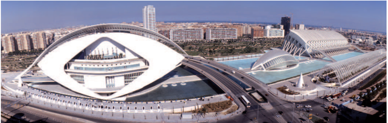
La sede de CAP VITAL SANTÉ España se encuentra ubicada en el seno de la Ciudad de las Artes y las Ciencias de Valencia.
